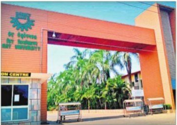
కళింగ ఇనిస్టిట్యూట్ ఆఫ్ ఇండస్ట్రియల్ టెక్నాలజీ (కిట్)
