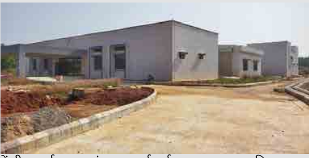
केंद्रीय कार्यशाला : ढांचागत कार्य पूर्ण। लगभग 96.18 प्रतिशत भवन निर्माण कार्य पूर्ण हो चुका है।
