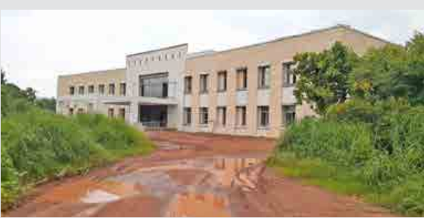
एसईओसीएस: स्ट्रक्चरल काम पूरा हुआ। लगभग 95.40 प्रतिशत भवन निर्माण कार्य पूर्ण हो चुका है।
