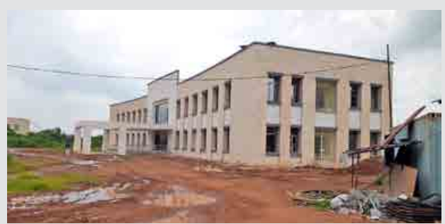
एसएचएसएसएम: संरचनात्मक कार्य पूरा हुआ। लगभग 95.88% भवन निर्माण कार्य पूर्ण हो चुका है।
