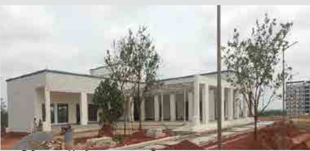
कमर्शियल कॉम्प्लेक्स (आवासीय): स्ट्रक्चरल का काम पूरा हो गया है और फिनिशिंग का काम प्रगति पर है। लगभग 94.50% भवन निर्माण कार्य पूर्ण
