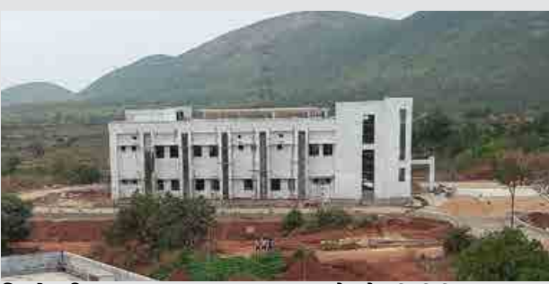
डिस्पेंसरी : स्ट्रक्चरल काम पूरा हो चुका है और फिनिशिंग का काम चल रहा है। लगभग 64.35 प्रतिशत भवन निर्माण कार्य पूर्ण।
