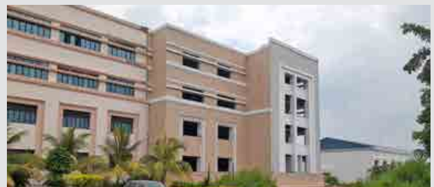
एसएमएस एक्सटेंशन: संरचना पूर्ण, पेंटिंग, एल्युमिनियम कार्य, फॉल्स सीलिंग कार्य, स्वच्छता कार्य, एचवीएसी और विद्युत कार्य जैसे परिष्करण कार्य प्रगति पर हैं। लगभग 71.70 प्रतिशत भवन निर्माण कार्य पूर्ण हो चुका है।
