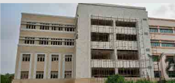
एसबीएस विस्तार: संरचना पूर्ण, झूठी छत, विस्तार संयुक्त, एल्युमीनियम कार्य, स्वच्छता कार्य, विद्युत कार्य, एचवीएसी कार्य प्रगति पर है। लगभग 78.60% भवन निर्माण कार्य पूरा हो गया है।
