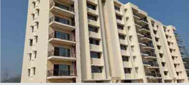
टाइप-डी1 और डी2 क्वार्टर: स्ट्रक्चरल काम पूरा हो गया है और फिनिशिंग का काम प्रगति पर है। लगभग 99.90% भवन निर्माण कार्य डी टाइप क्वार्टर में पूरा किया गया।
