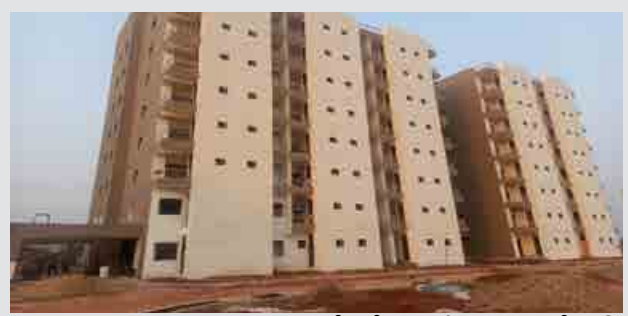
दक्षता छात्रावास : संरचनात्मक कार्य पूर्ण तथा परिष्करण कार्य प्रगति पर है। लगभग 84.62 प्रतिशत भवन निर्माण कार्य पूर्ण हो चुका है।
