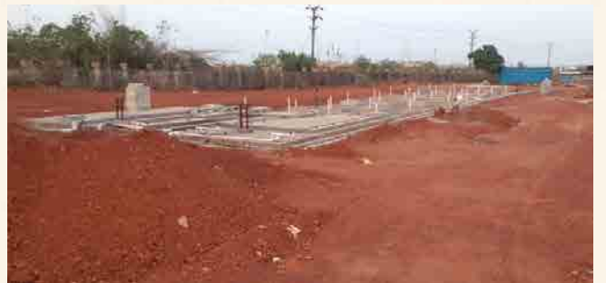
एसटीपी: एसटीपी काम के लगभग 90% पूर्ण ।
